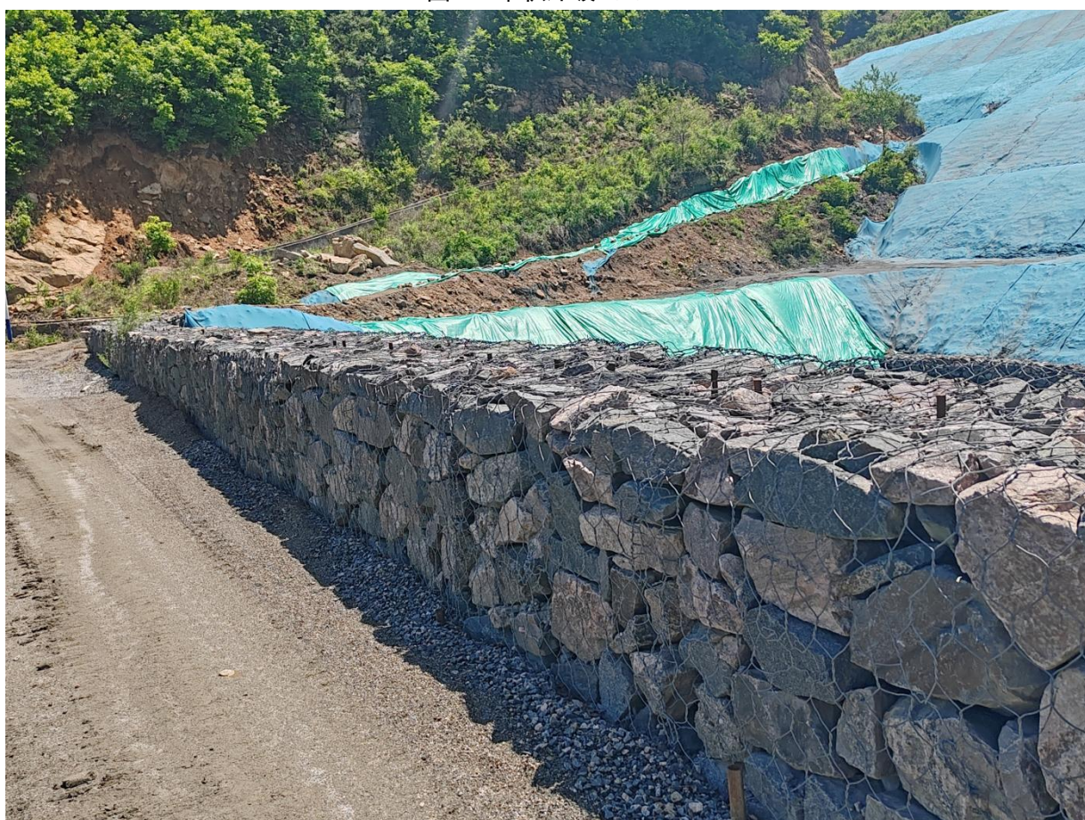
图 2-6 坝顶石笼挡墙
